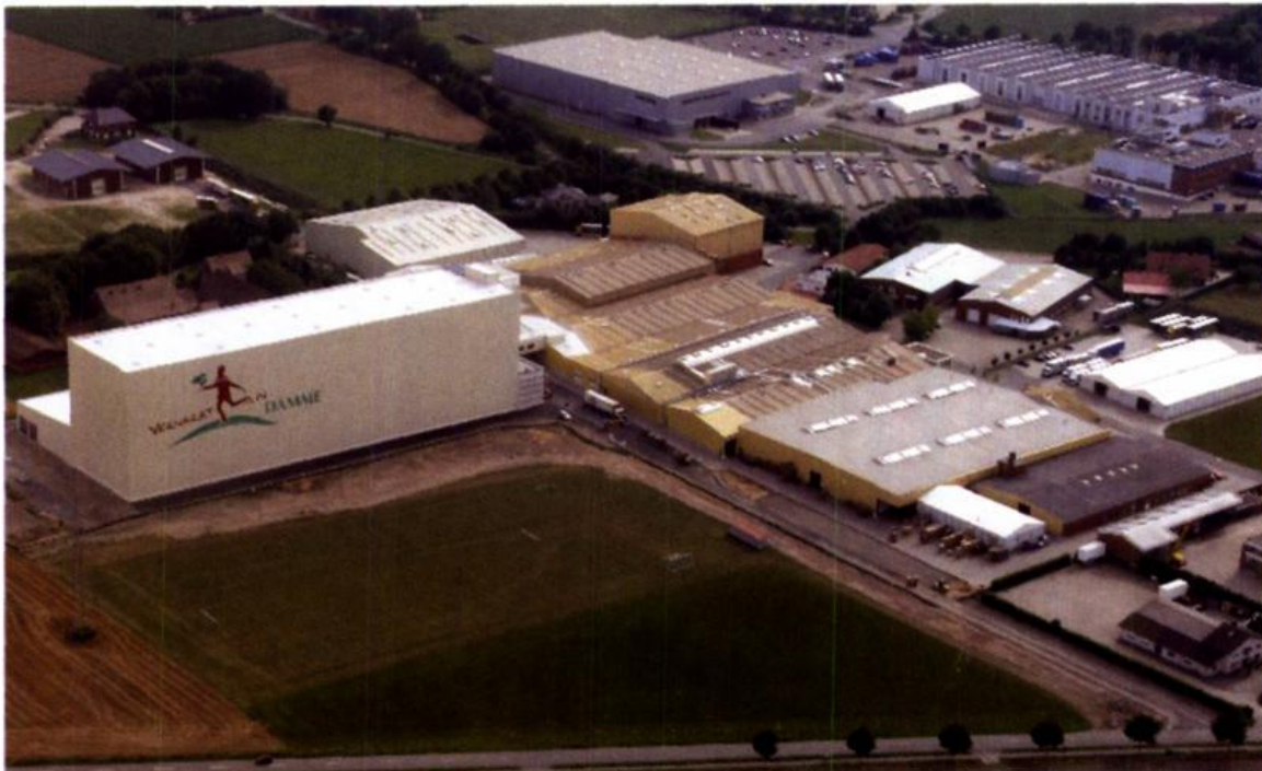
Abb. 6: Das Firmengelände der Zerhusen Kartonagen GmbH im August 2010; auffallend ist das neue Hochregallager mit dem Logo der Stadt Damme
