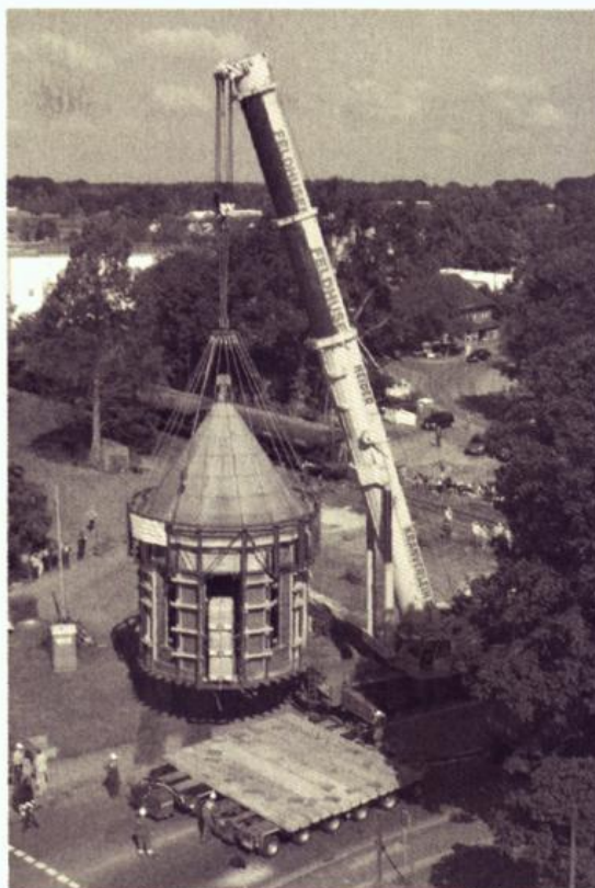
Abb. 1: Ein Schwerlastkran hebt das Ehrenmal vorsichtig von seinem alten Standort auf einen gekoppelten, doppelten Tieflader.
