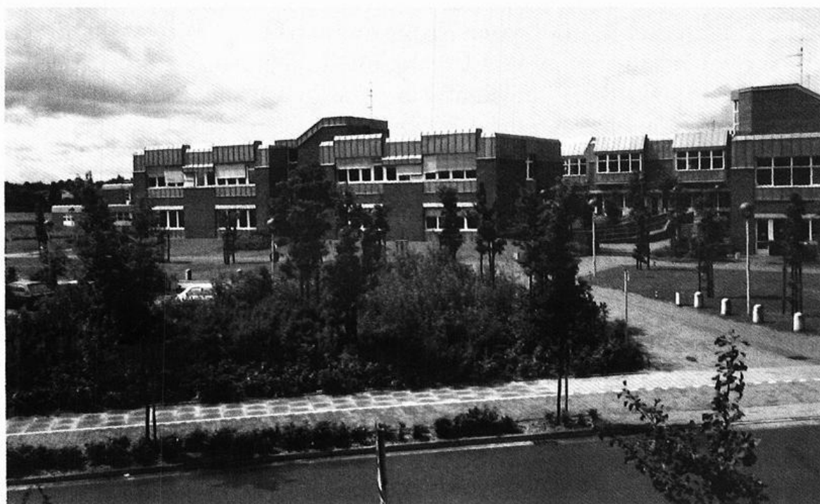
Abb. 6: Die 1983 übergebenen Campus-Gebäude mit Bibliothek, Mensa und N-Trakt, von Osten her gesehen. Foto: unbekannt
