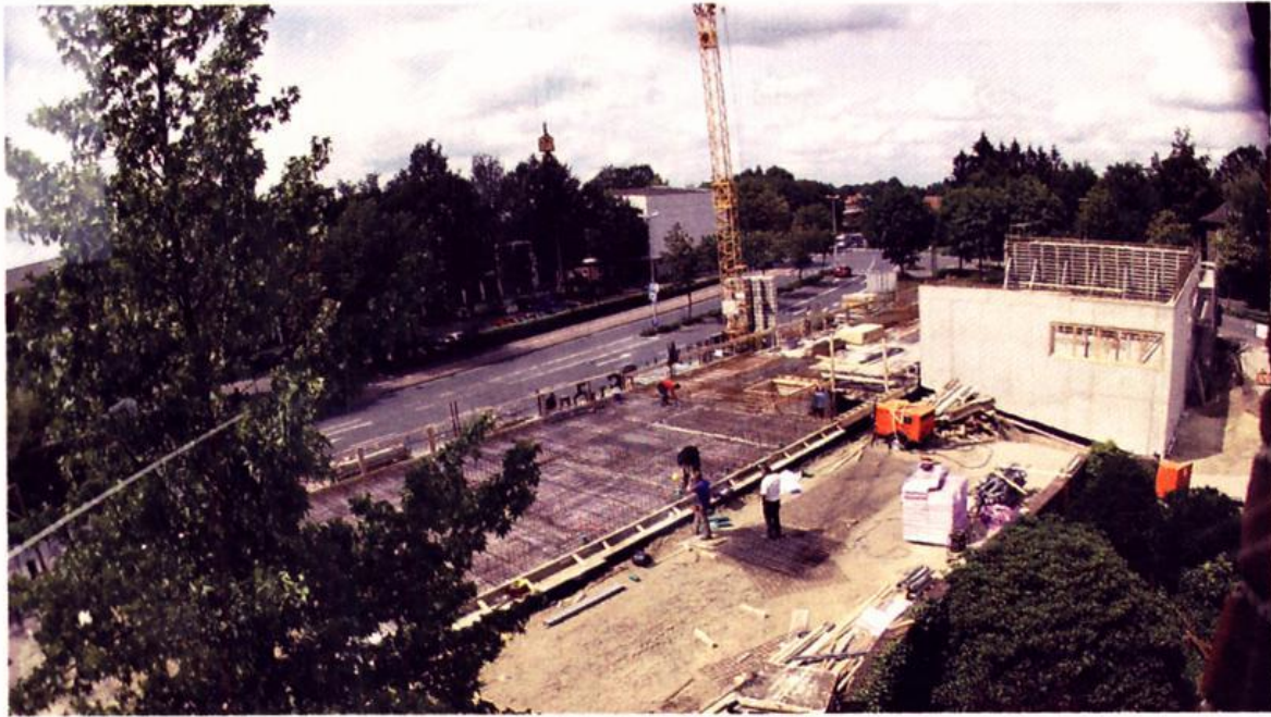
Abb. 7: Neubau des Hörsaalgebäudes, das 2012 fertiggestellt sein soll. Stand der Bauarbeiten im Juli 2011 Bild: Pressestelle der Universität Vechta
