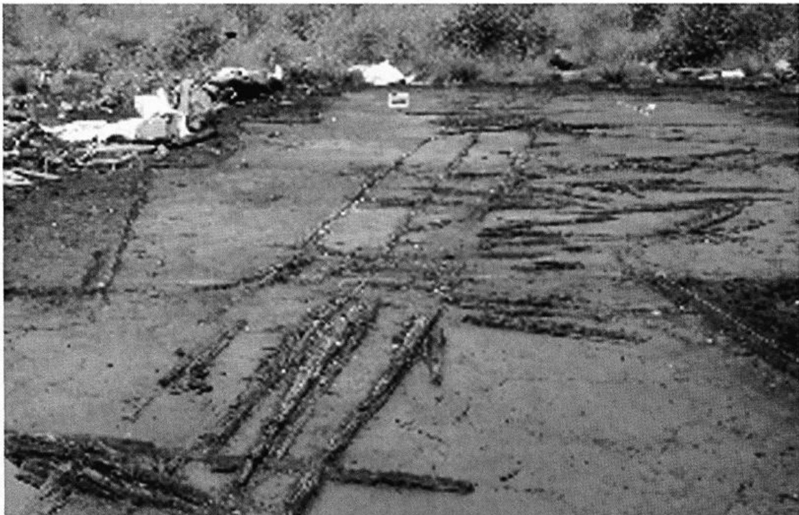
Abb. 6: Pfahlweg Pr 36. Die Lauffläche ist teilweise vom Unterbau abgeschwemmt.
