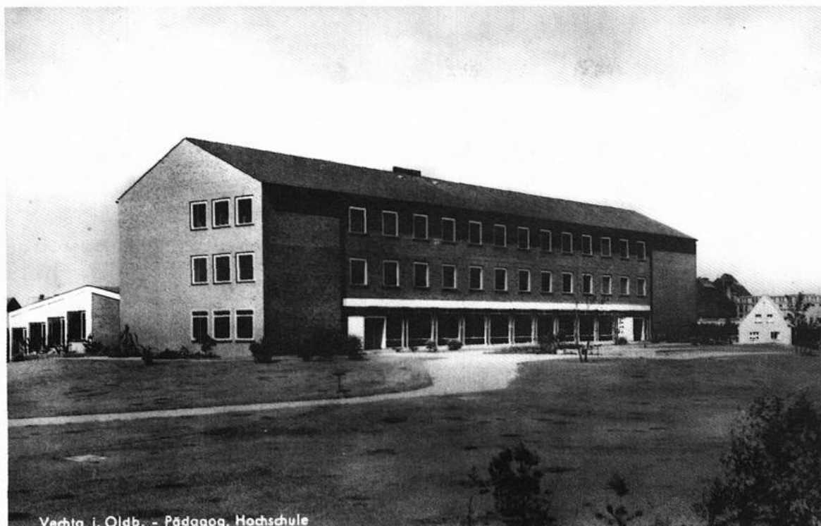
Abb. 5: Der erste, 1961 bezogene Neubau der PH an der Driverstraße; heutiger A-Trakt mit Hörsaal B1, von Osten her gesehen.
