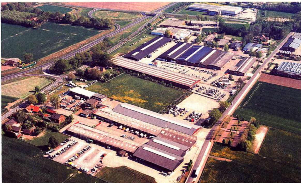
Abb. 6: Das Lastruper Betriebsgelände der Fahrzeugwerke Böckmann; links oben im Bild ist die im Jahre 2009 fertig gestellte Ortsumgebung zu erkennen Foto: Fahrzeugwerke Böckmann
