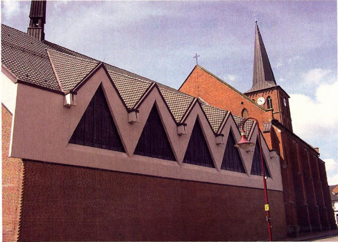
Abb. 3: Die St. Petrus-Kirche in Lastrup, im Vordergrund ist der in den 1970er-Jahren errichtete Anbau zu erkennen Foto: Gemeinde Lastrup
