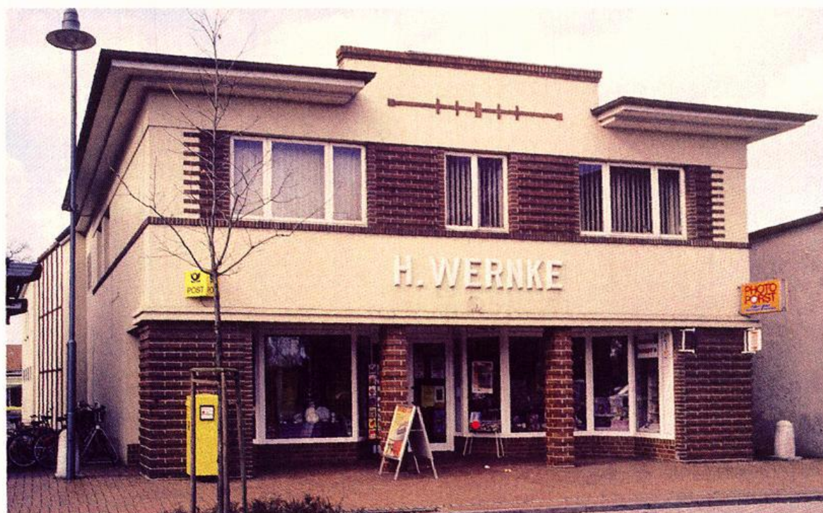
Abb. 3: Ein weiteres Beispiel für das internationale Bauen im Landkreis Vechta ist die ehemalige Klempnerei Wernke 1933/34 mit ihrem Kontrast einer verputzten und einer steinsichtigen Klinkerfassade.
