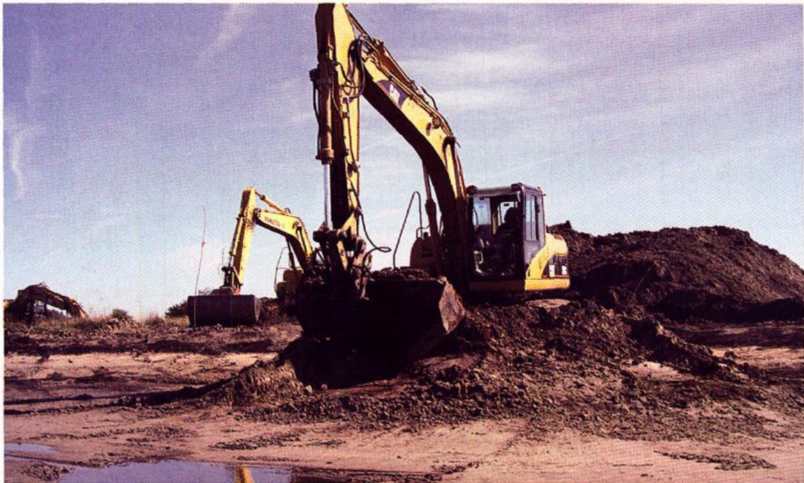
Abb. 6: Zur Neuanlage von Amphibien-Laichgewässern ist der Einsatz schweren Geräts erforderlich.
