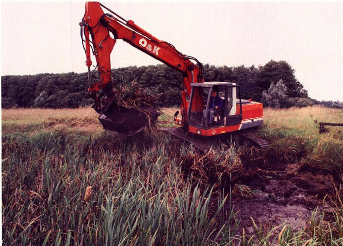
Abb. 10: Sanierung eines weitgehend verlandeten Gewässers mit dem Bagger
