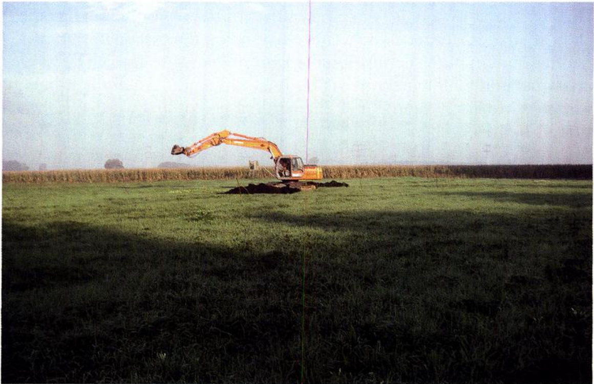
Abb. 7: Baubeginn des ersten AMPHIKULT-Gewässers im Oktober 2010 Foto: M. Richter
