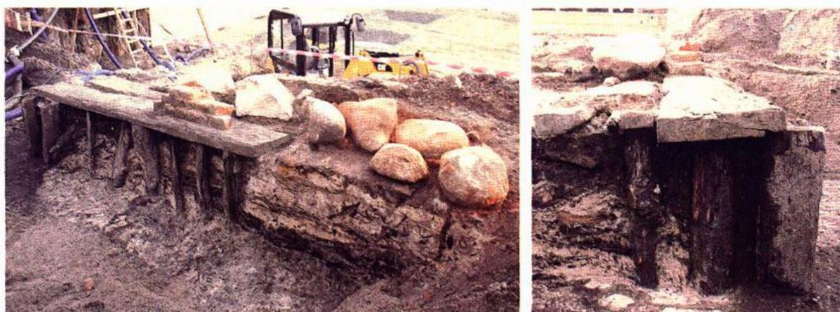
*Abb. 9: Die südlichste Pfahlkonstruktion mit einem Fundament aus Findlingen (Blick nach Nordosten und Süden)*
