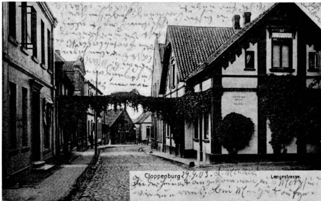
Abb. 1: Die Langestraße in Cloppenburg um 1900 mit dem Haus der Firma „Becker & Co.“ Foto: Archiv Museumsdorf
