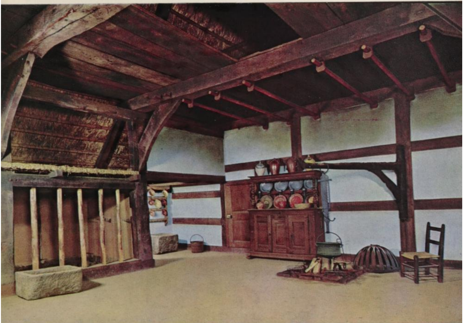
Inneres des kleinräumigen Müllerhauses (Rauchhaus ohne Schornstein).
