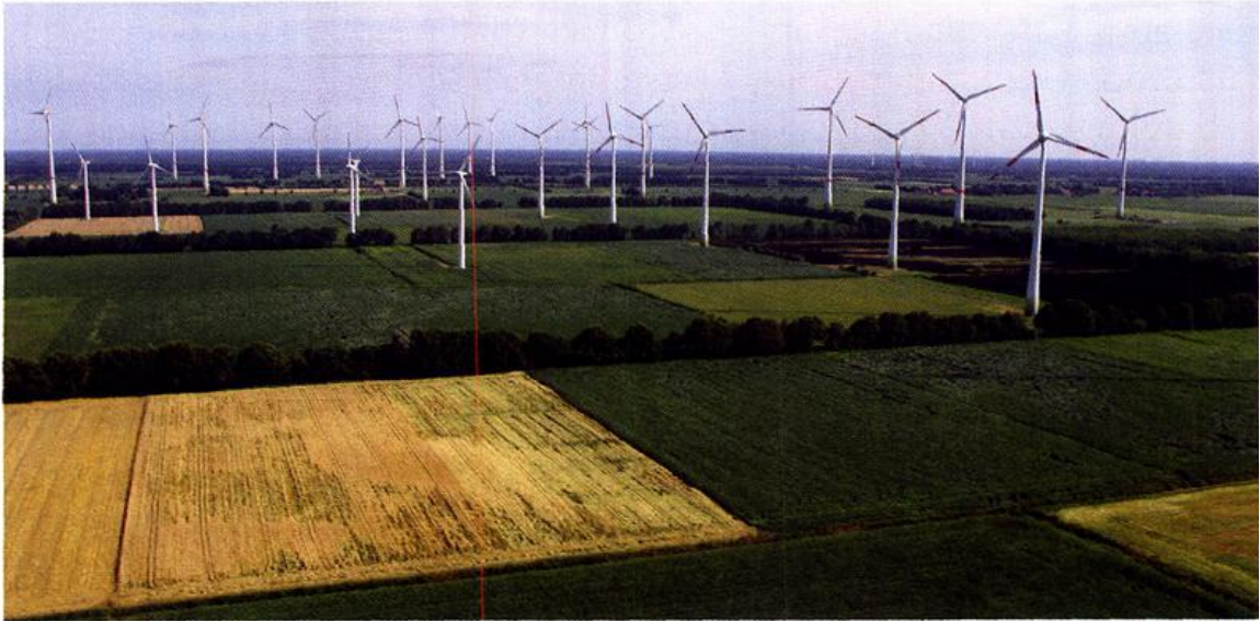
Abb. 5: Der fertiggestellte Bürgerwindpark Saterland
