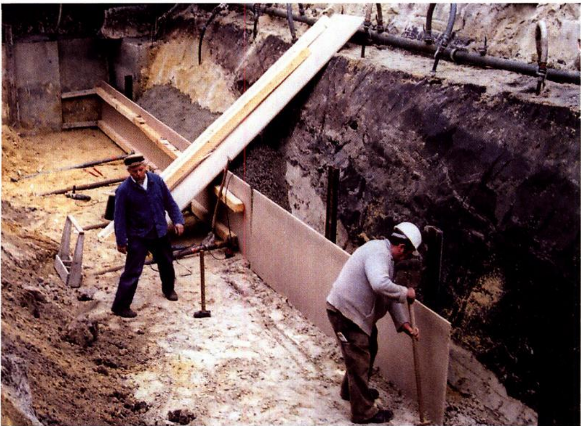
Abb. 7a und 7b: Freigelegtes Stadtgrabenprofil beim Aushub der Baugrube für den Neubau der Marien-Apotheke um 1980
