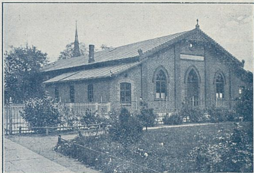
Alte Turnhalle am Steinweg.
