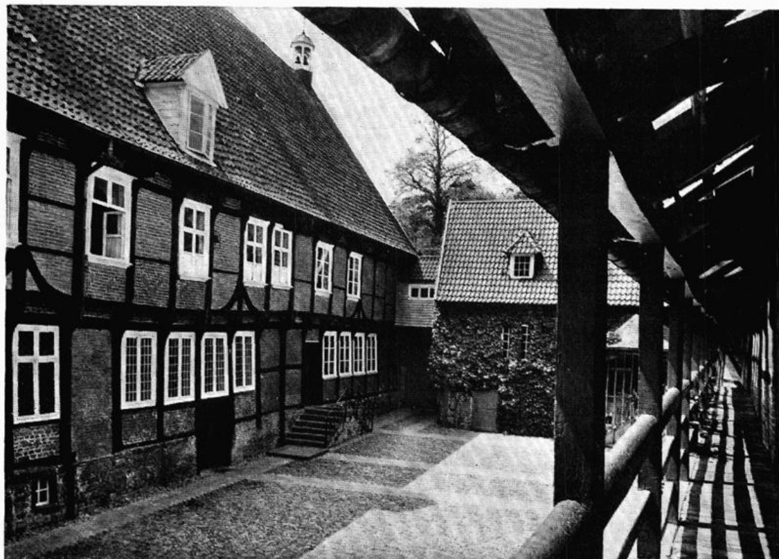
Bild 2: Blick in den Burghof. Links Wohnhaus, rechts Stallungen mit einer Galerie dem sog. Apostelgang, an dem die Schlafzimmer der Söhne lagen.
