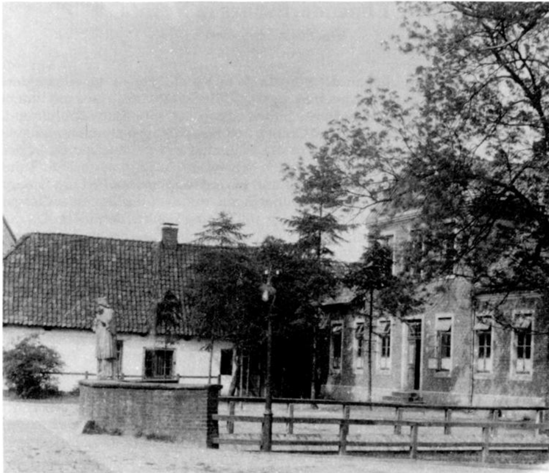
Abb. 1 Die Elmendorffsburg und die alte Rektorwohnung in Vechta um 1922. Die Nepomukstatue wurde 1923 zur anderen Brückenseite versetzt, als man das Feuerwehrgerätehaus baute. Foto: H. Gräf.
