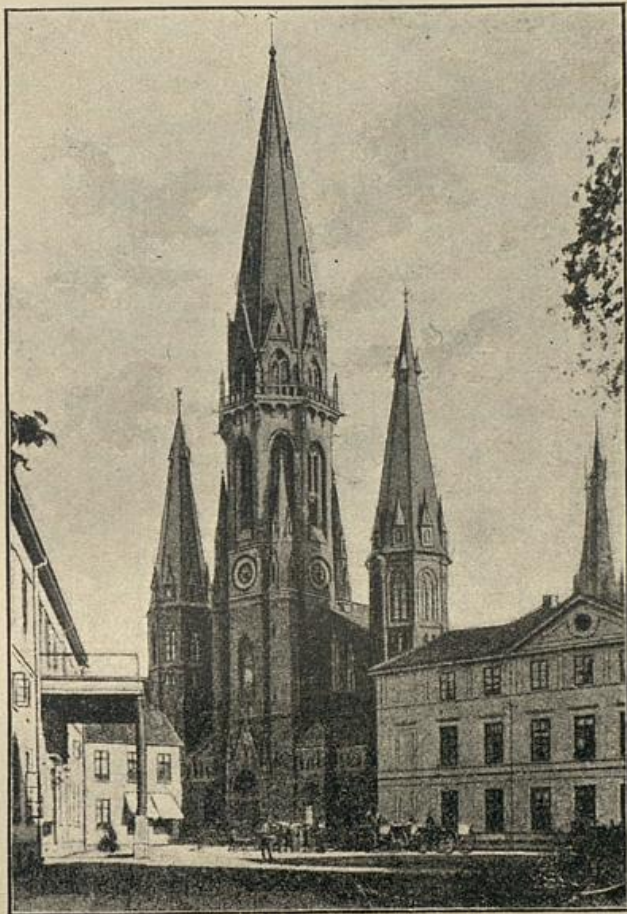
Ansicht der Lambertikirche nach ihrem äußeren Umbau.
