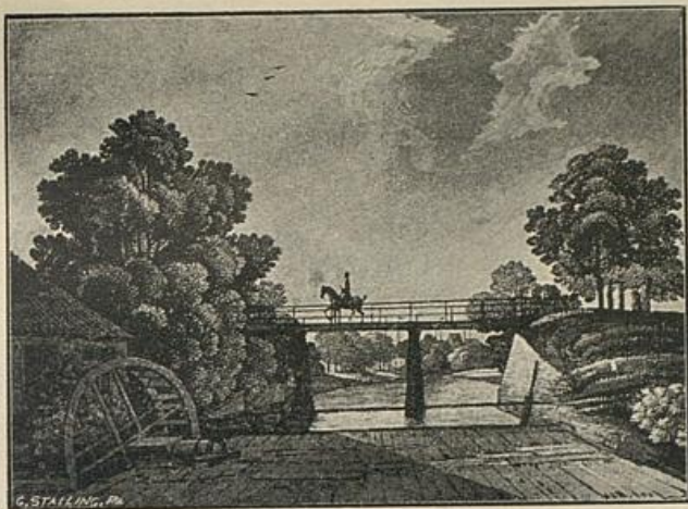
Die „hohe Brücke“.
