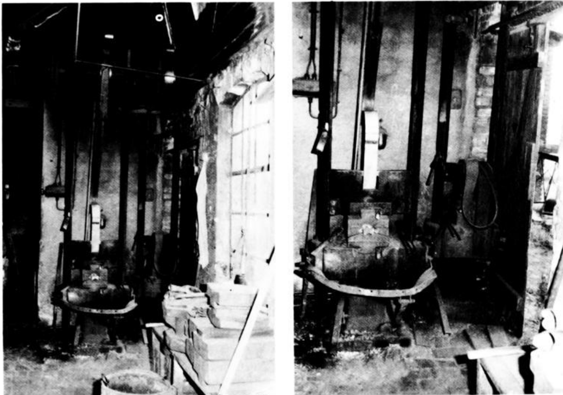
Abb. 10 und 11: Zwei Fallhämmer (Riemenhämmer) zum Biegen der Spatendüllen und zum Schlagen im Gesenk (rechts im Bild Gesenke zum Formen und Aufgraten von Schaufelblättern).
