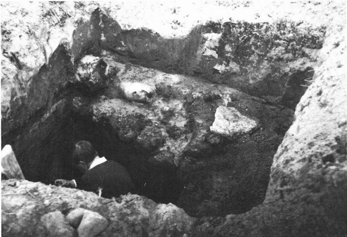
Das Fundament wurde entdeckt
