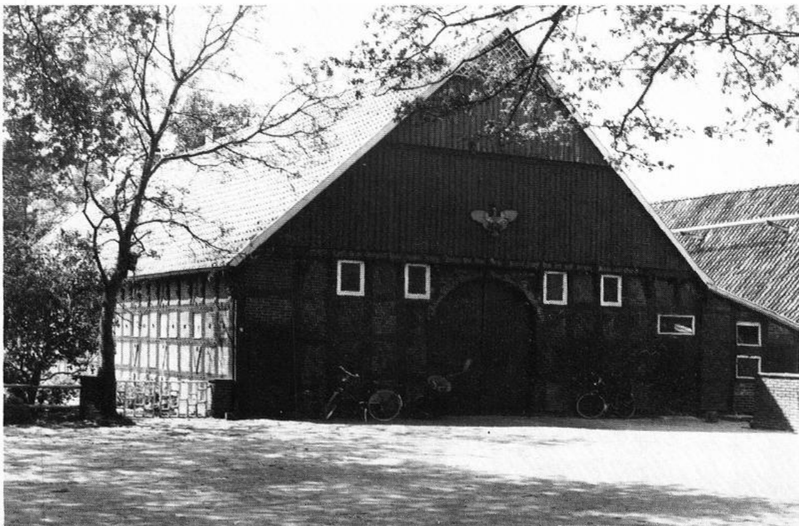
Der Brunklaus Hof in Ehren, errichtet noch während der Zeit der Zehntpflicht im Jahre 1811.
