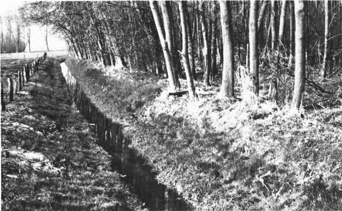
Vertieft und begradigt ähnelt der Calhorer Mühlenbach mehr einem Graben denn einem Fließgewässer. Durch die wasserbaulichen Maßnahmen unterliegen die angrenzenden Feuchtwälder verstärkt der Austrocknung. (Aufn. nördl. der Calhorer-Sevelter Straße)
