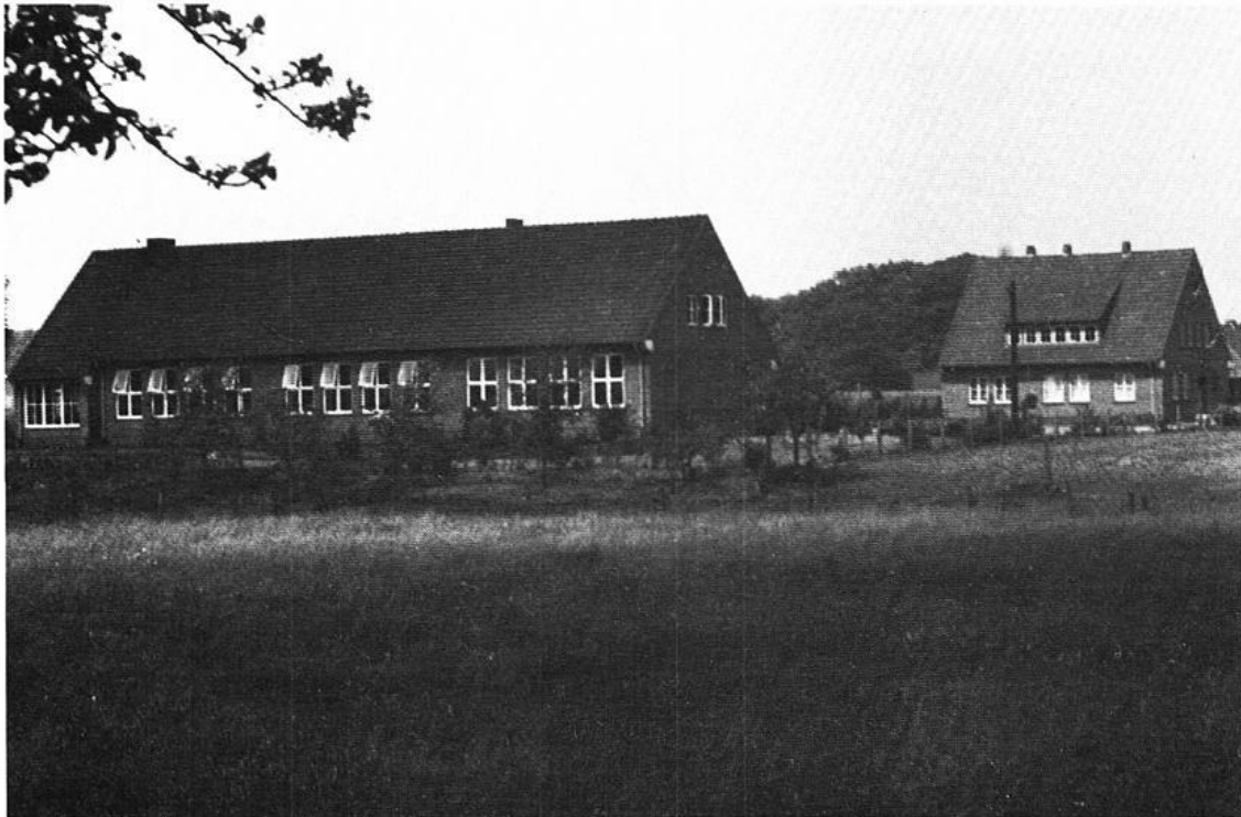
Foto 1956, W. Schultze. Sie wurde 1965 erweitert und ist heute eingegrünt.
