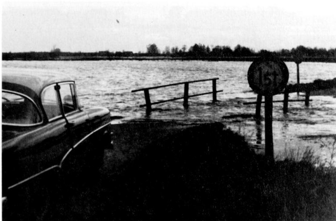
In Sedelsberg stand die Brücke im Zuge der Gerhard-Unland-Straße vor dem Ausbau der Straße und der Begradigung der Ems unter Wasser.
