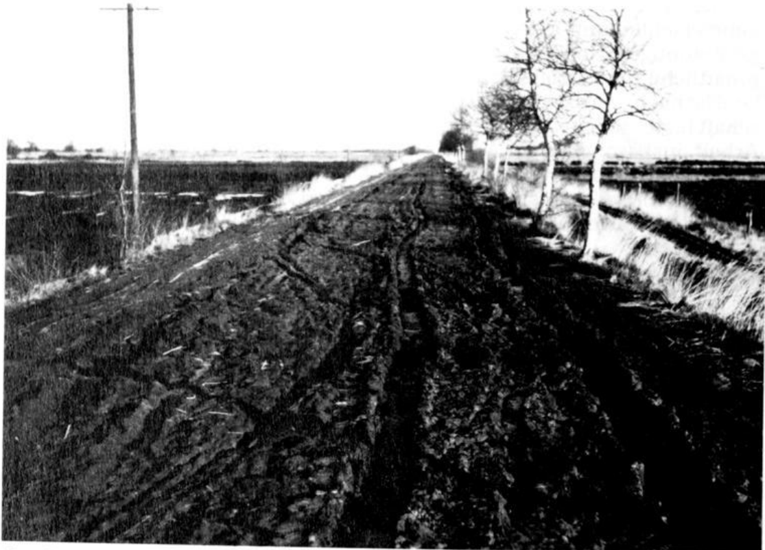
Der Scharrelerdamm vor seinem Ausbau. Er ist eine wichtige Verbindungsstraße nach Oldenburg.
