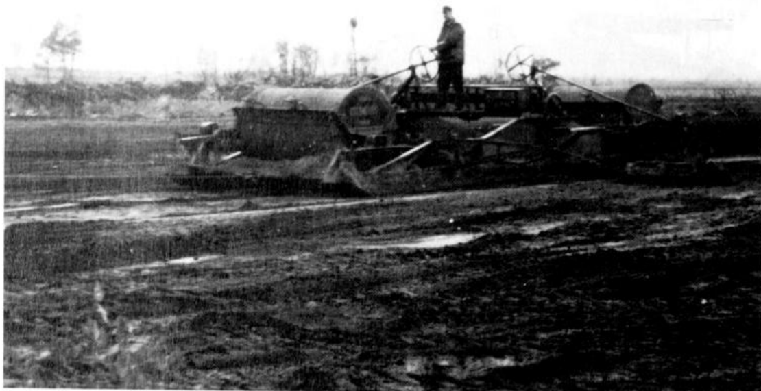
Nach dem Tiefpflügen wurde das Gelände mit dieser Maschine planiert.
