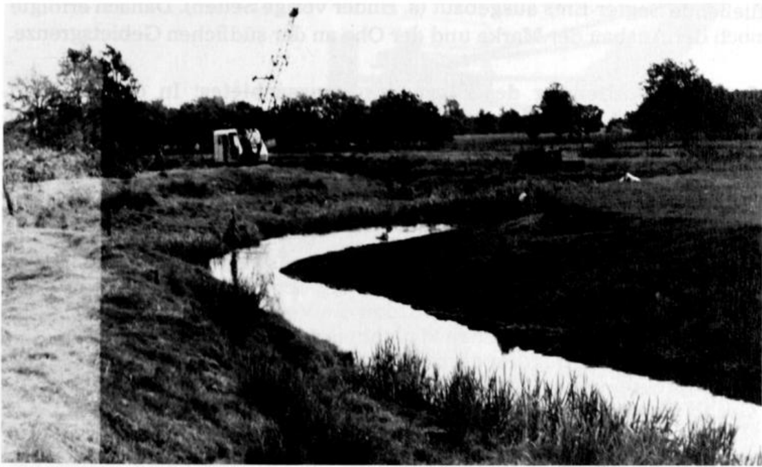
Die Sagter-Ems im alten Zustand, im Hintergrund der Bagger.
