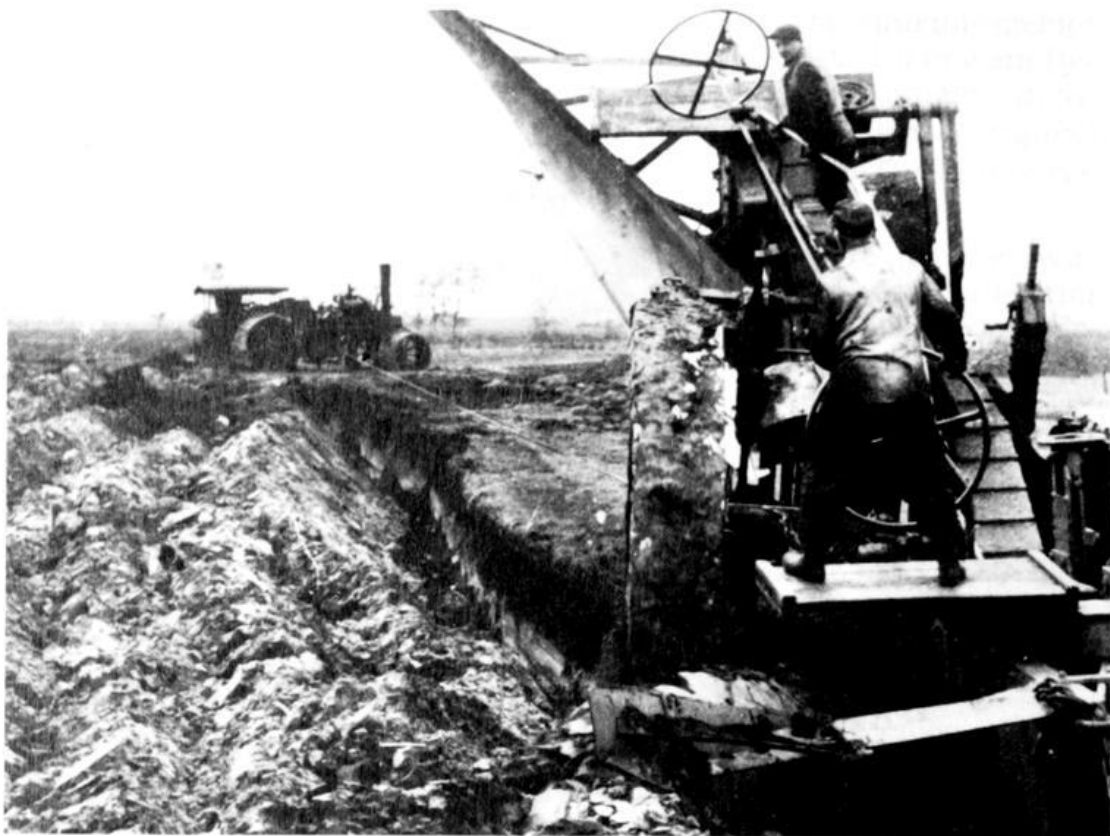
Bis zu einer Tiefe von 1,80 m wurde der Boden tiefgepflügt.
