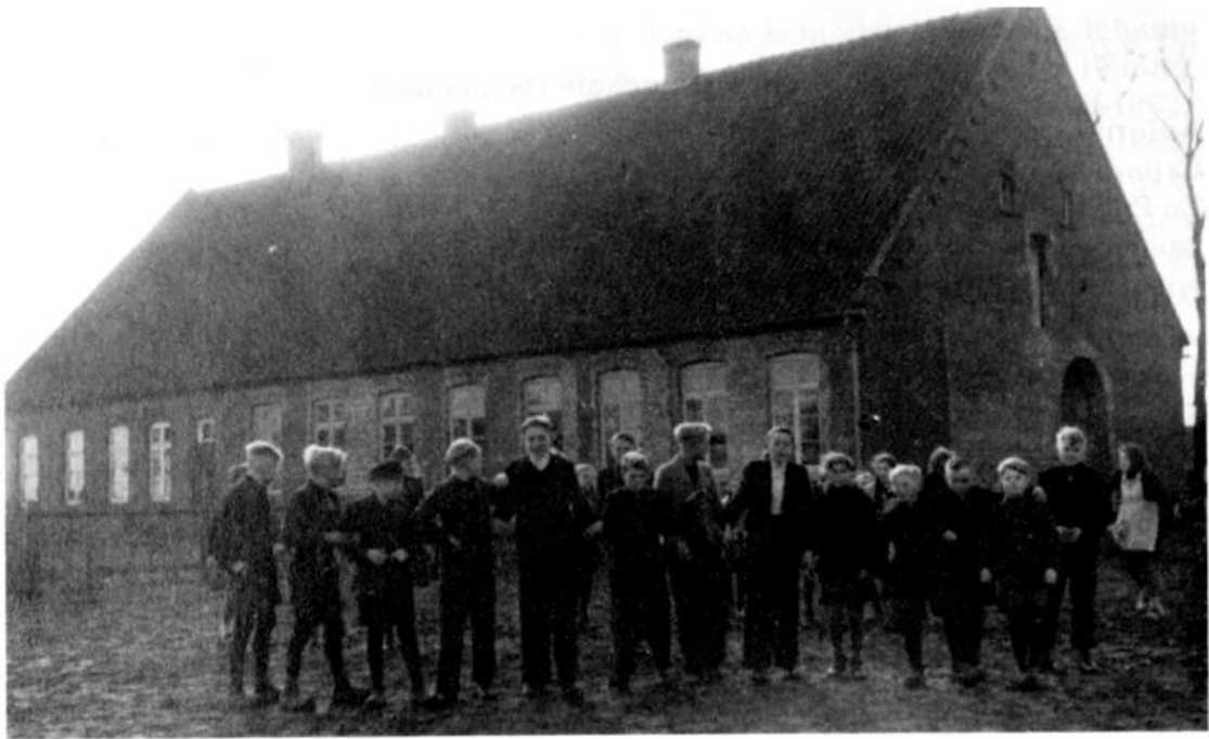
Alte Schule Harpendorf. Abbruch 1964
