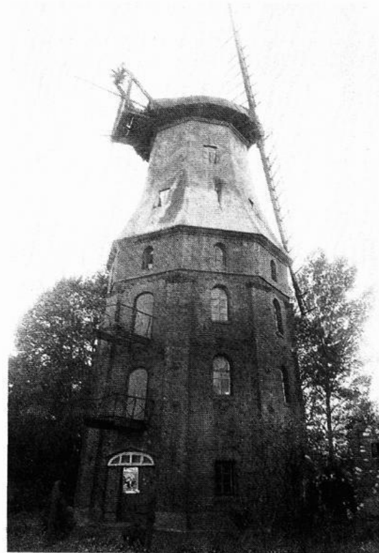
Die Barbeler Windmühle nach der Teil-Restaurierung im Jahre 1983.
