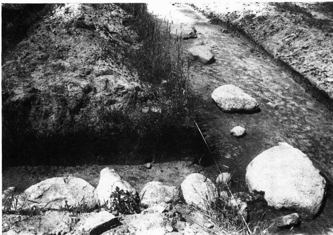
Grabung Zitadelle Vechta 1983. Fundamente der NO-Ecke des Kommandantenhauses – Stallteil.
