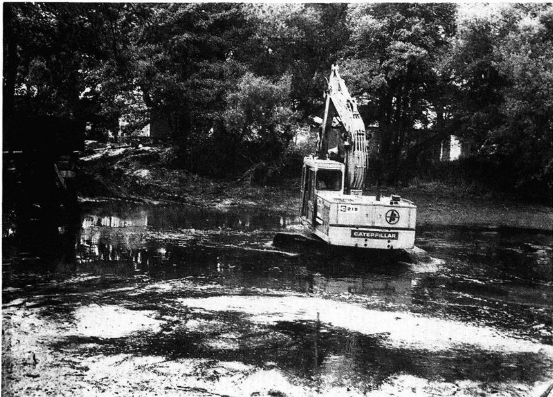
Burg Lethe 1982. Der Bagger versucht den Mühlenteich zu entschlammen.
