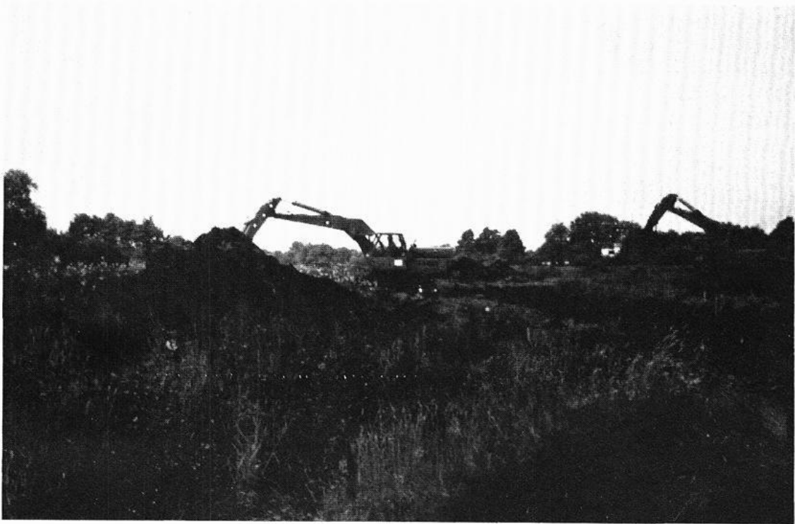
Grundräumung der Marka, einem Ausbau gleichend.
