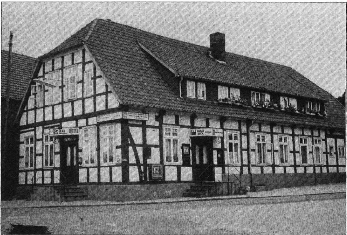
Hans Bünнемeyer kurz vor dem Abbruch 1977.
