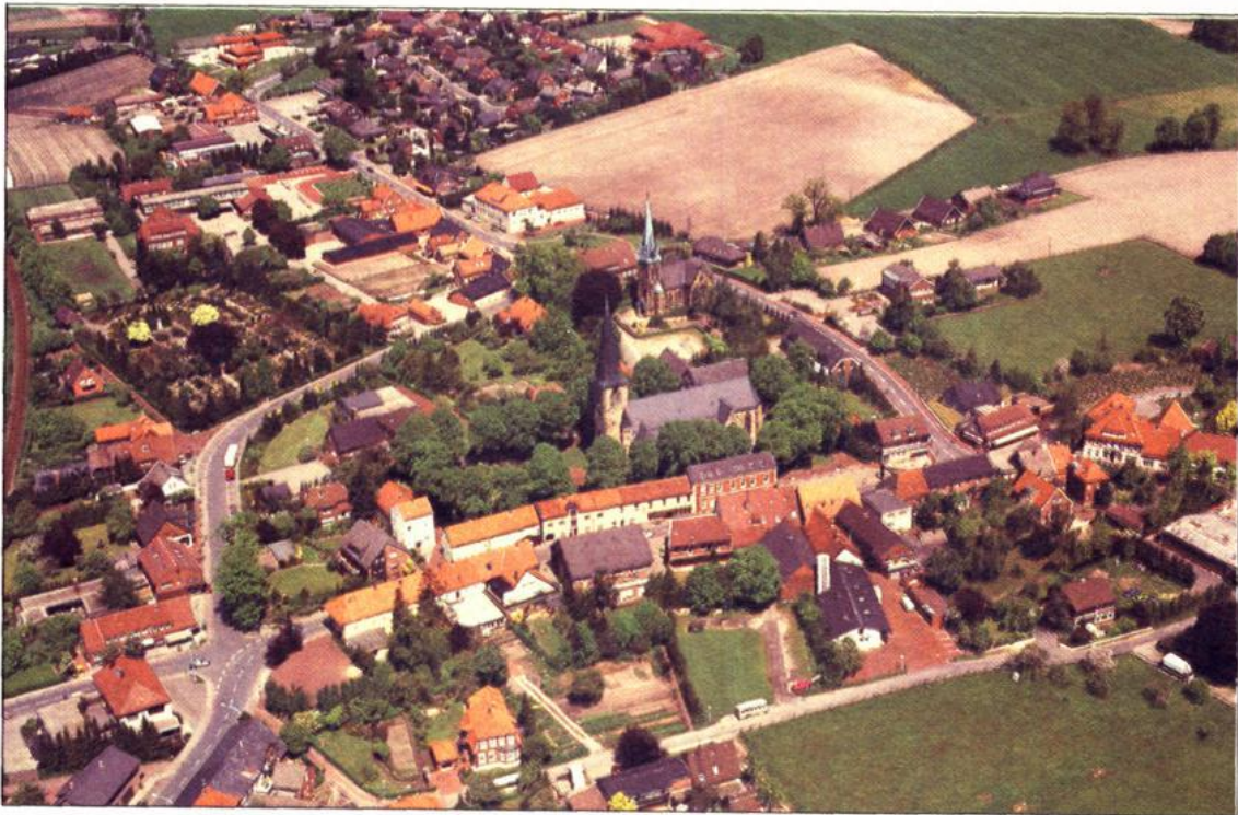
Neuenkirchen Ortsmitte 1987. Foto: Karl-Heinz Geweke Freigegeben am 2. 9. 1987 unter Nr. 0412 durch Bez.-Reg. Weser-Ems.
