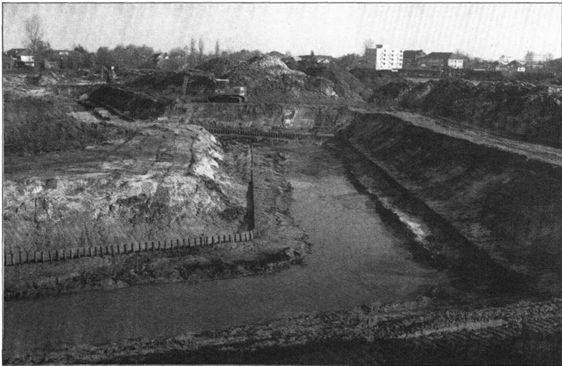
Foto 5: Zitadelle Vechta. Erdarbeiten zur Erstellung des Stadtparkes. Foto C. Popko
