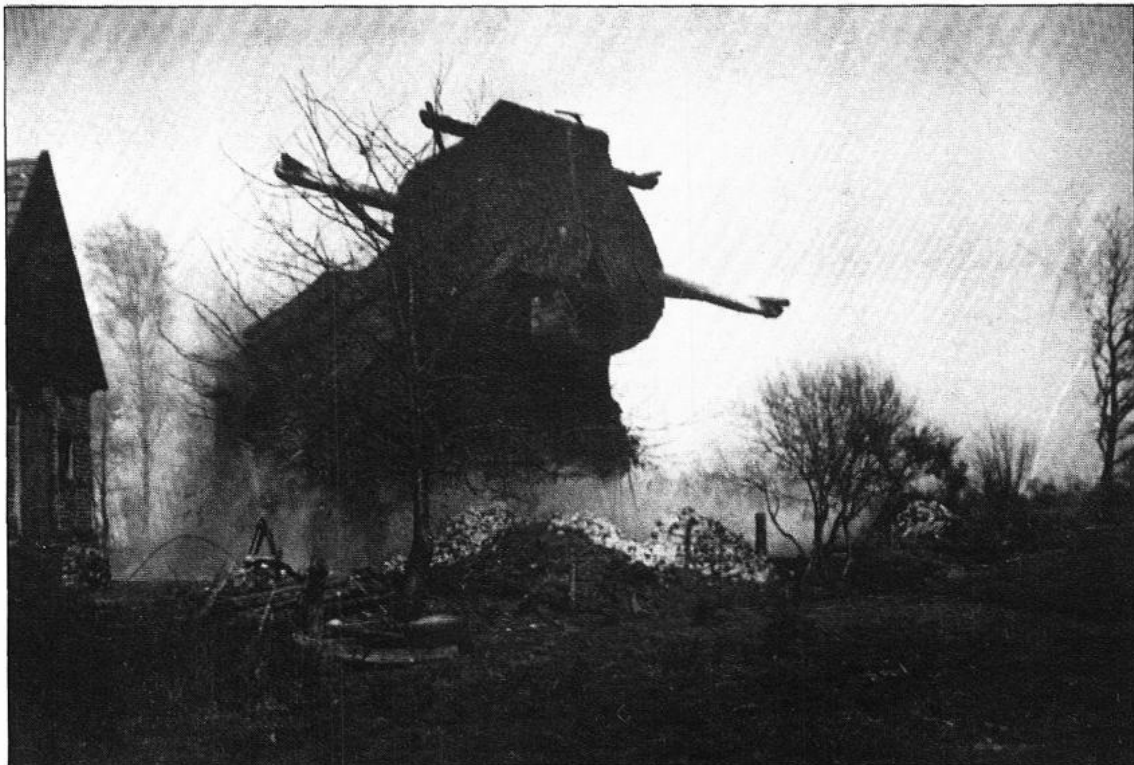
Abbruch der Kalvelager Mühle im April 1935
