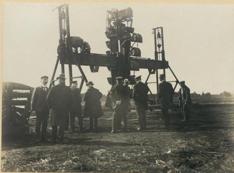
GROSSER STRENGE-BAGGER Teilansicht / Tägliche Leistung in 3 Schichten bis 13\frac{1}{2} Waggon
