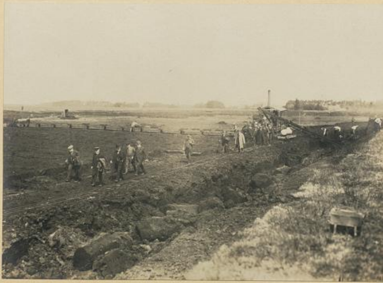
TORFWERK KLEINSCHARREL Gesamtansicht der Dolberg-Pressen / Links der Transporteur
