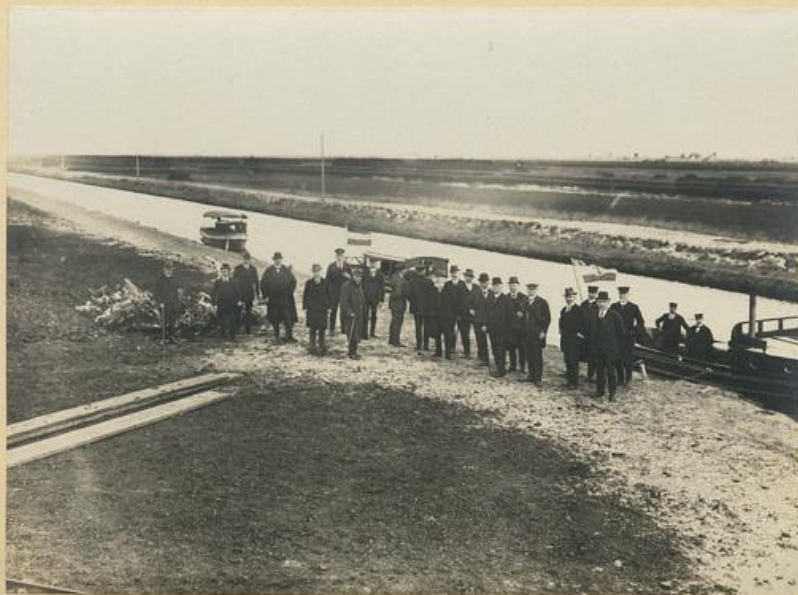
AM KANAL BEI KAMPE
