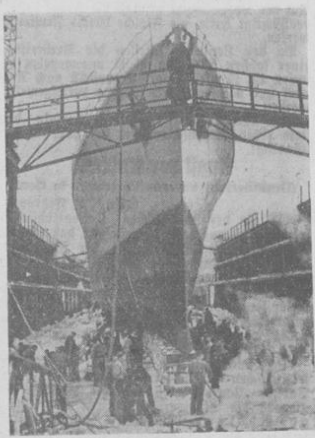
Auch in den Docks wird Schnee gehaufelt. Unter Bild zeigt Schneereinigungsarbeiten auf einer deutschen Werft. (P.A. Sannet, Presse-Soffmann)
