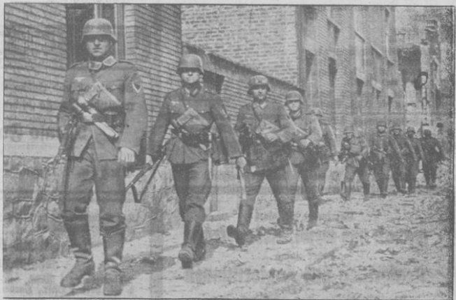
Spähtrupp stößt in eine Stadt vor
