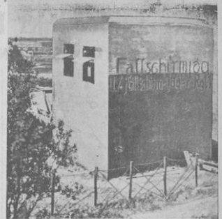
Ein holländischer Bunker.
