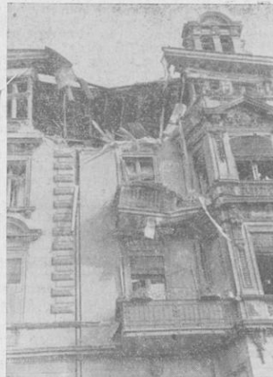
Ein durch britischen Bombenwurf beschädigtes Berliner Wohnhaus (Presse-Bild-Zentrale)
