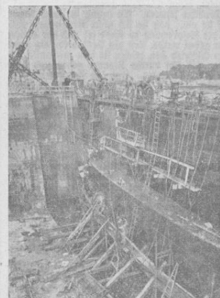
Wiederherstellungsarbeiten an der Kanalküste. Ein französisches Trockendock wird wieder instandgesetzt. (Presse-Hoffmann)
