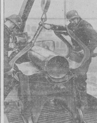
Eisenbahngeschütz in Feuerstellung. Im Munitionswagen werden Granaten und Kartuschen bereitgestellt. Ein Kranwagen bringt die Ladung zum Geschütz. (PK. Tritschler, Atlantic.)
