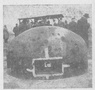
Ein Beobachtungssturm des Werkes „Hochwald“, von deutschen Geschossen durchschleibt.
