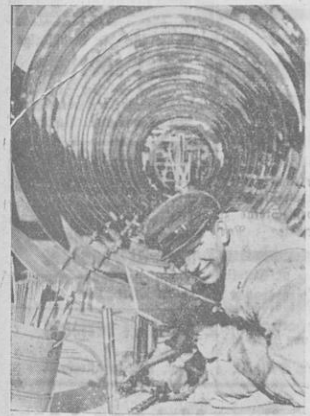
Am Druckkörper des Unterseebootes gibt es für den Schweißer viel Arbeit. (Atlantic, Hubmann)
