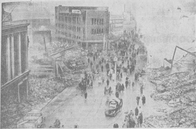
Die Mitte dieser mittelenglischen Rüstungsstadt, deren Name zum Begriff für alle in Trümmer gelegten englischen Städte geworden ist, wurde in ein wahres Trümmerfeld verwandelt, wie unsere Aufnahme, die uns auf dem Umweg über Newyork erreichte, zeigt. (Presse-Hoffmann.)
