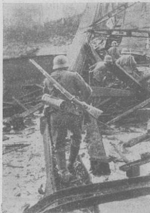
Im Sturmlauf geht ein Stoßtrup über die Trümmer der gesprengten Brücke zum Angriff vor. (PK. Tannenber, Scherl)
