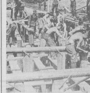
Nur noch einige Handgriffe und schon steht auch diese neue Brücke dem Vormarsch zur Verfügung. RAD-PK-Aufnahme: Ofm. Flemmiger.
