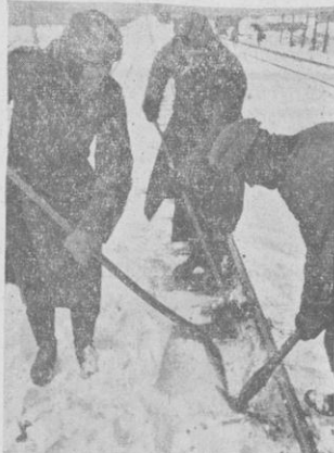
Auch bei Schnee geht die Arbeit weiter. Vor dem Umnageln der Eisenbahnschienen in der Sowjetunion auf deutsche Normalspur werden sorgfältig Schnee- und Eiskrusten beseitigt. PK.-Aufnahme: Kriegsberichtler Schürer (Atl.)
