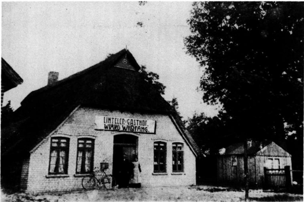
Abb. 93: Hof Ahlers (Nr. 45), Baujahr 1818, Umbau 1893, nach altem Foto von 1907/08 (mit frdl. Erlaubnis von Rolf Spille, Delmenhorst).
