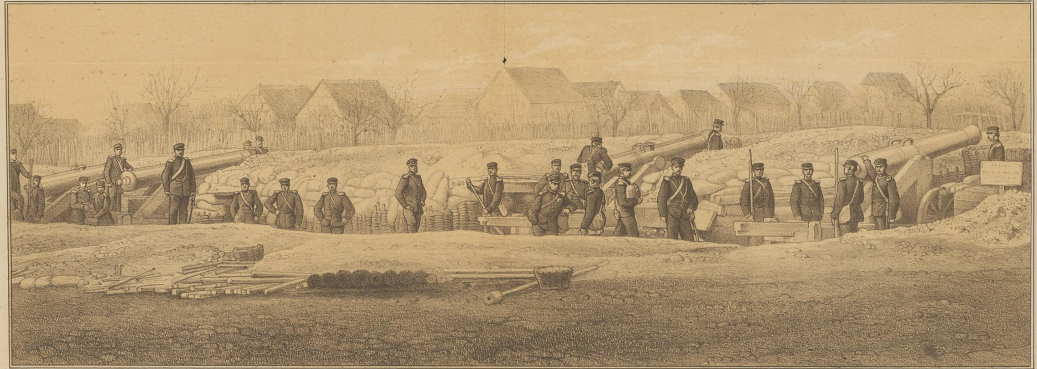
Batterie 2 vor Neu-Breisach.
