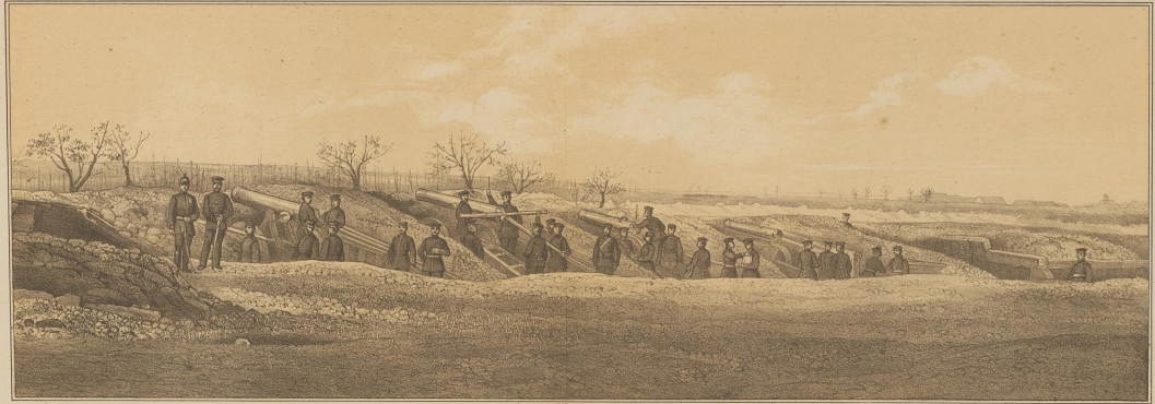
Batterie 1 vor Neu-Breisach.
