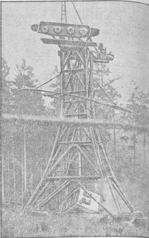
Die Trümmer der abgefallenen Kabine am Fuße eines Males der Drahtseilbahn bei Freiburg i. B.
