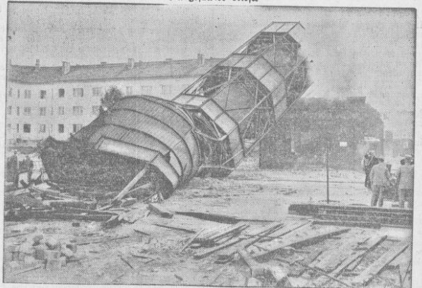
Umgelegter alter Wasserturm auf dem Gelände der Gasanstalt Berlin-Weihensee. — Um die hohen Kosten für den Gefäßbau bei einem regelrechten Müßiggang zu ersparen, wurde der Stahlteil einfach durch Sprengung umgelegt.
