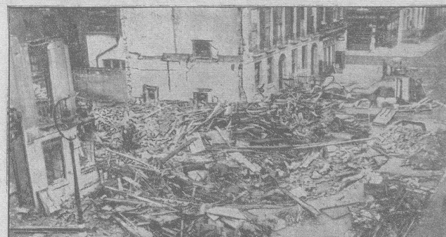
Trümmer über Trümmer in den Straßen Londons Diese Überreste eines Betriebsbetriebes lagen mehrere Wochen herum, ehe daran gedacht werden konnte, die Strassen herumzumachen und zu säubern. Die noch lebenden Mauern wurden wegen Einsturzgefahr hinter von englischen Pionieren endgültig gesprengt. (Associated Press/Sonder-Multiflex-A)
